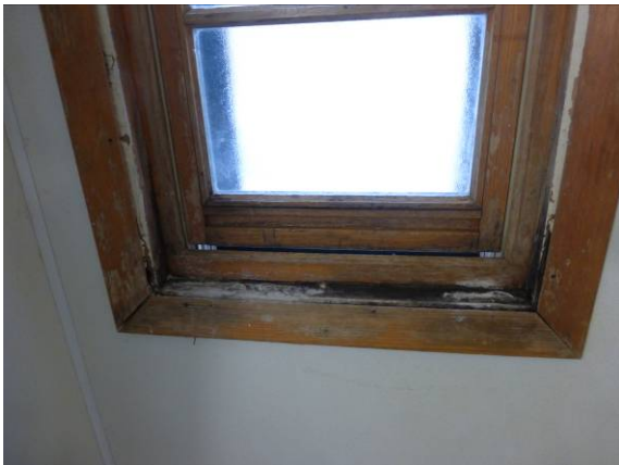
Photo #45: Tenant unit window
