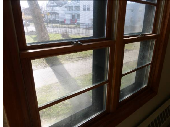
Photo #44: Tenant unit window
