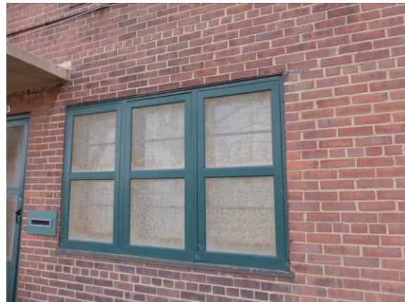
Photo #28: Tenant unit window
