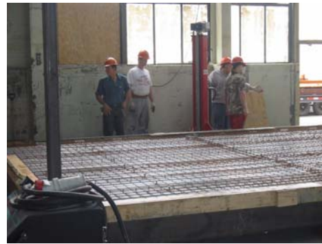
Figure 52 Floor ready for concrete pour
