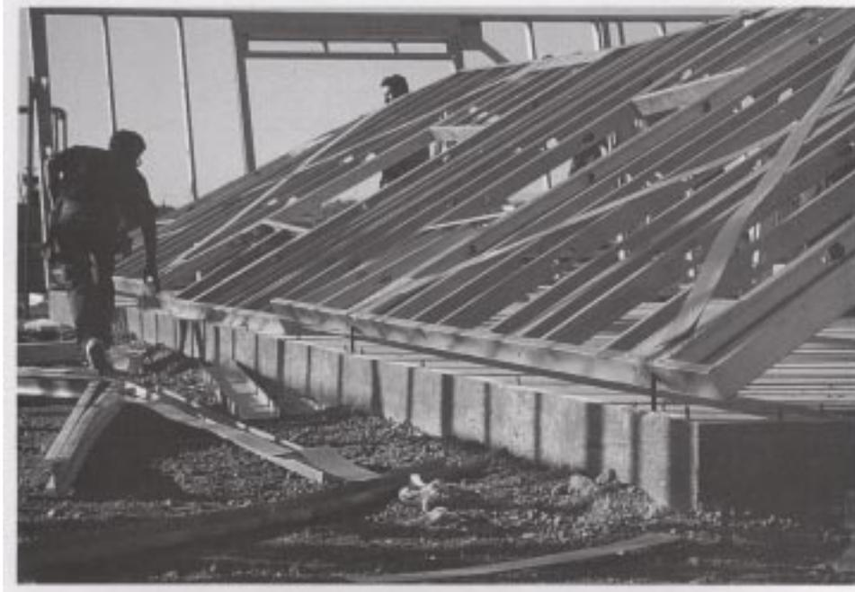
**Photo 9. LIGHT-GAUGE STEEL WALLS BRACED IN POSITION**
