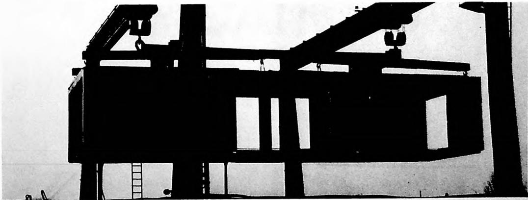
FACTORY-CAST STRUCTURAL CONCRETE BOX MODULE
