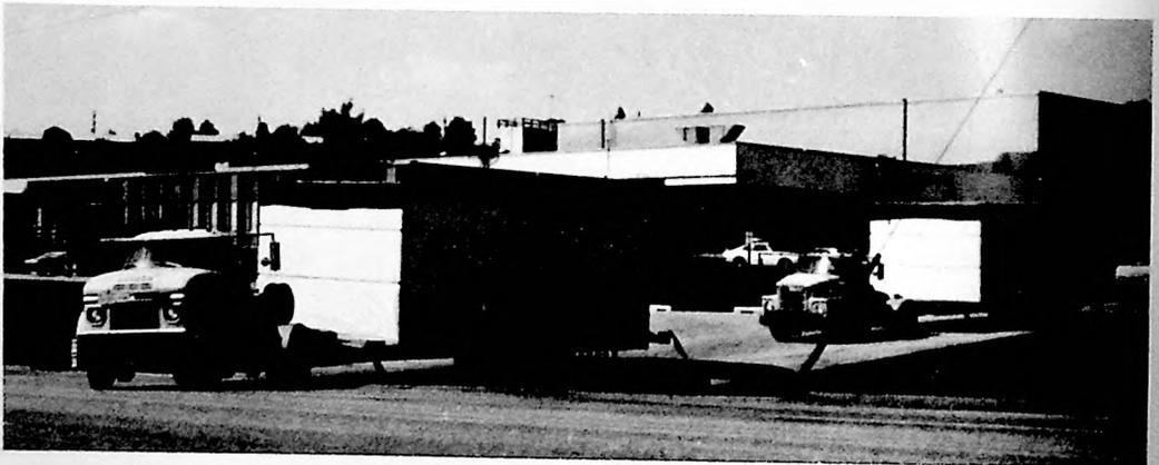
COMMON CARRIER LEAVING G.E.'S FACTORY FOR 1135 MILE TRIP TO MEMPHIS, TENN. WITH CAST-PLASTER WALL MODULES
