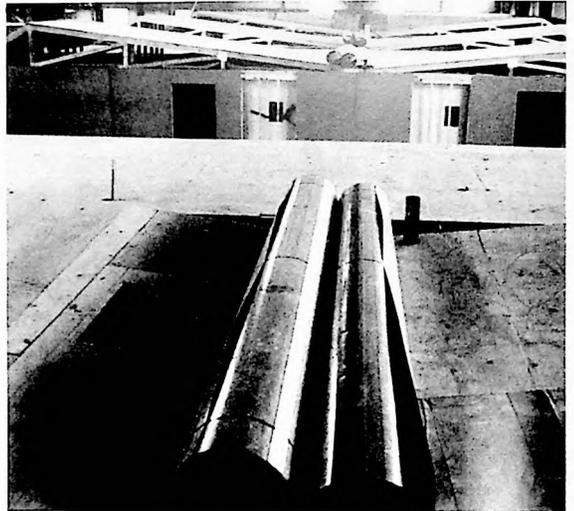
INSTALLATION OF 30 GAUGE GALVANIZED SHEET STEEL ON MODULE TOP AT SCHOLZ FACTORY
