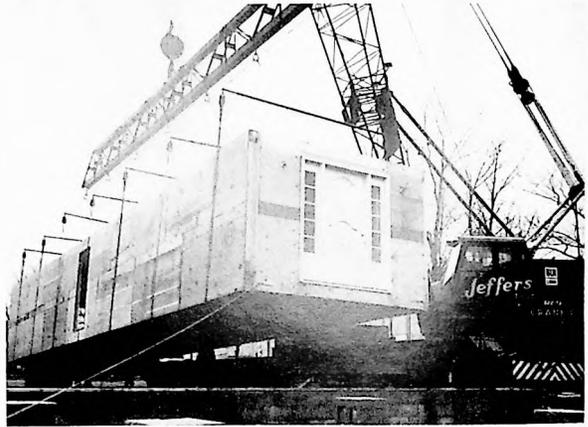
SCHOLZ MODULE BEING LIFTED AT ERECTION SITE
