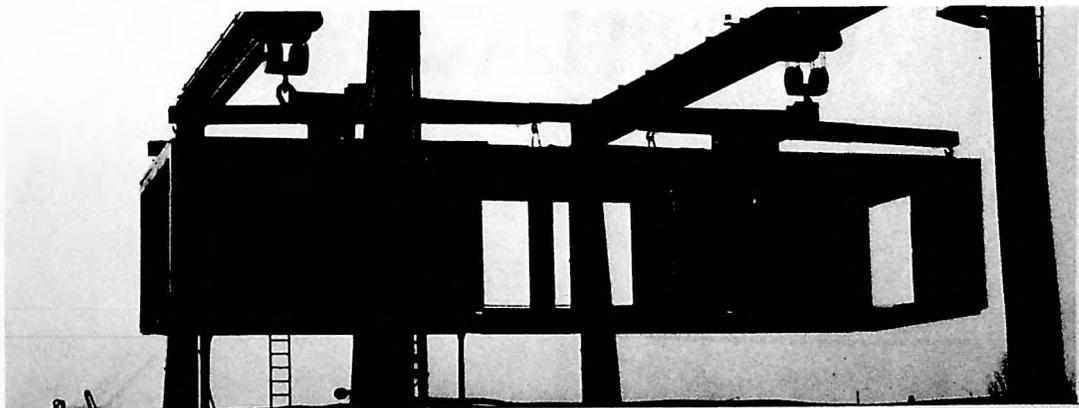
FACTORY-CAST STRUCTURAL CONCRETE BOX MODULE
