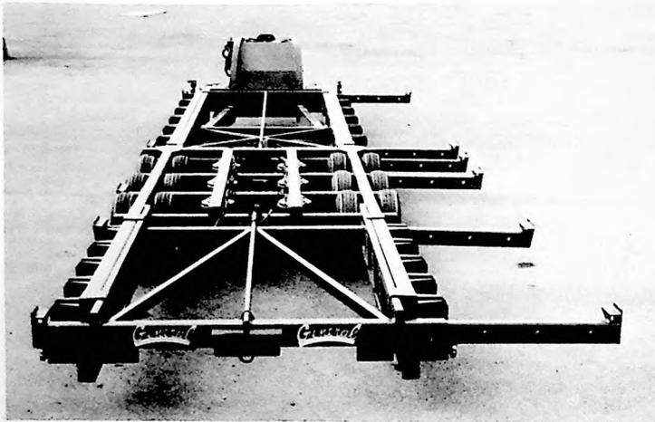
EXPANDABLE MODULE CARRIER SHOWING PNEUMATIC-RIDE LEVELLING SYSTEM LOCATED BETWEEN THE BOGIES
