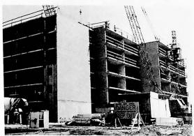
FCE-DILLON'S CORE AND PANEL SYSTEM UNDER CONSTRUCTION AT ONE OF THE PROTOTYPE SITES
